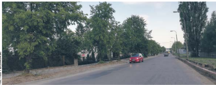
Trwa modernizacja ulicy Mazowieckiej.
