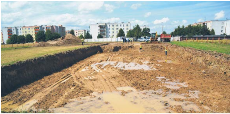
Na budowie trwają prace ziemne.
