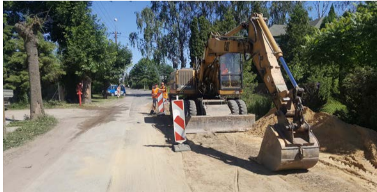
Rozpoczęła się modernizacja ul. Kwiatowej.
