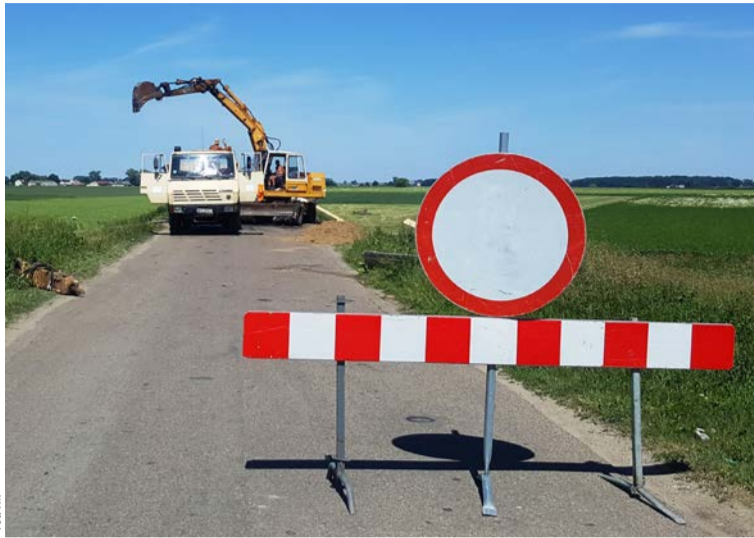
Trwa przebudowa mostu na rzece Sonie w miejscowości Kąty.
