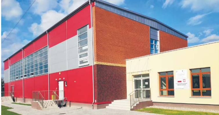
Hala sportowa z zewnątrz...
