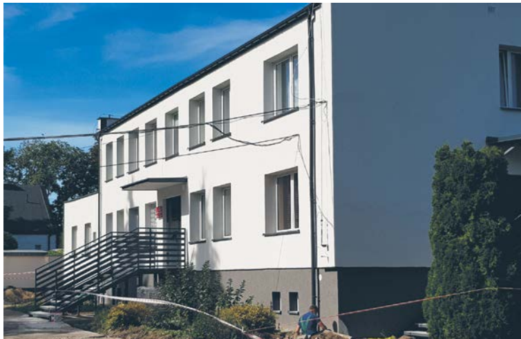
Budynek administracyjny został poddany termomodernizacji.
