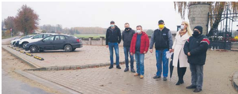
Odbiór miejsc parkingowych przed cmentarzem parafialnym w Zeńboku.
