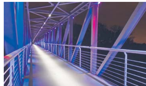
Ul. Ceramiczną z ul. Marii Skłodowskiej-Curie połączy wiadukt pieszo-rowerowy.
