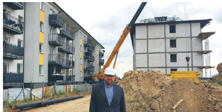
Prezes TBS Łukasz Lewandowski często osobiście dogląda postępów prac na placu budowy nowego bloku przy ul. Szwanke.
