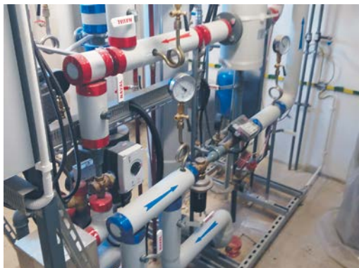
PEC pozyskał 8,5 mln zł bezzwrotnej dotacji na modernizację systemu ciepłowniczego.
