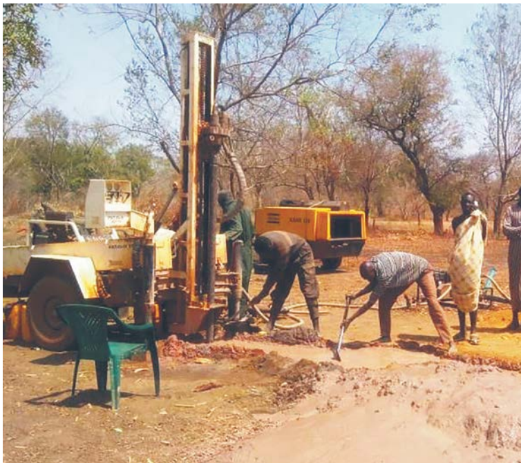
Początek budowy „ciechanowskiej” studni w Sudanie Południowym.
