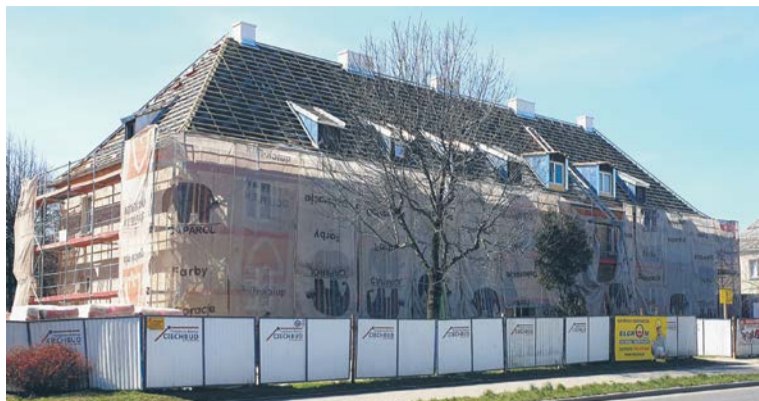
Trwa modernizacja kilku budynków na osiedlu „Błoki”.
