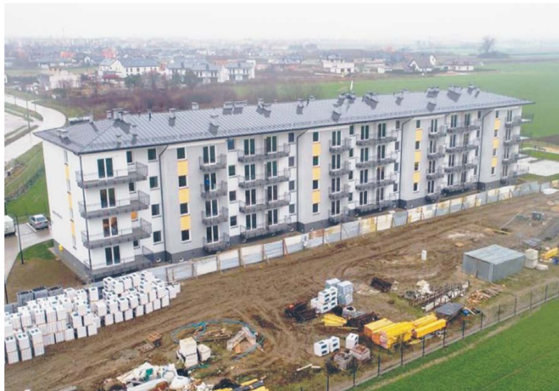
Towarzystwo Budownictwa Społecznego w Ciechanowie rozpoczęło budowę kolejnego budynku mieszkalnego przy ulicy Szwanke.
