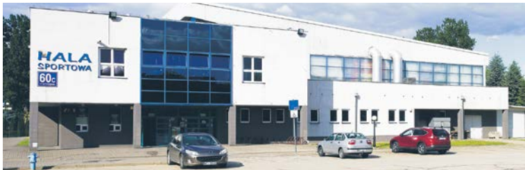
Hala widowiskowo-sportowa przy ul. 17 Stycznia 60 C.
