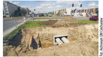
Przedsiębiorstwo Energetyki Ciepłej rozpoczęło modernizację głównej magistrali ciepłowniczej.
