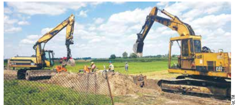
TM Na placu budowy kanalizacji w Grzybowie praca wre.
