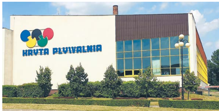
Na krytej pływalni zostanie przeprowadzony remont szatni.
