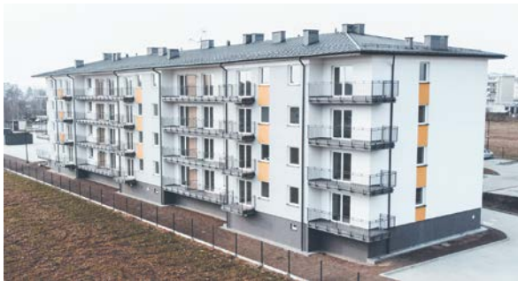
Nowy blok z 36 mieszkaniami wybudowany przez TBS przy ul. Szwanke.
