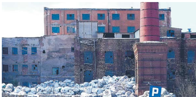
Na terenie byłej cukrowni zalegają tony odpadów.
