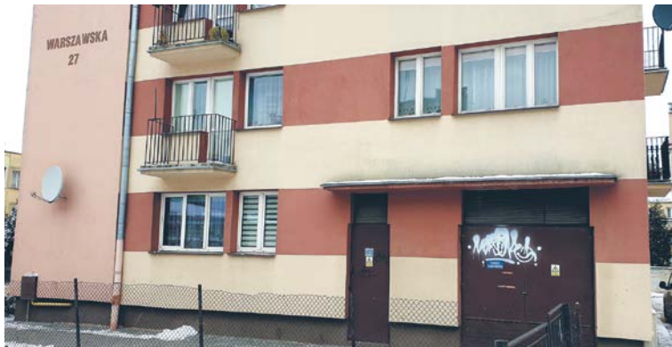
Wejście do pomieszczeń stacji transformatorowej w bloku przy ul. Warszawskiej 27 w Ciechanowie.
