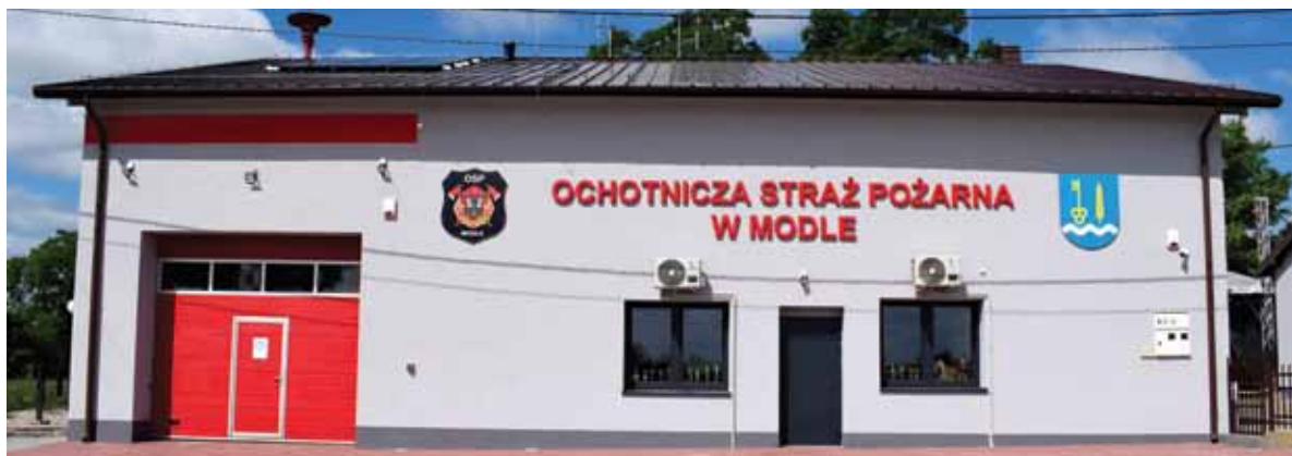
Obiekty OSP Modła przeszły gruntowną modernizację
