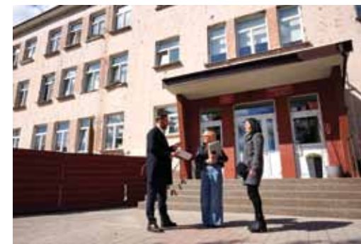
Prezydent Krzysztof Kosiński zapoznał się z zaawansowaniem prac remontowych budynku Szkoły Podstawowej nr 6.
