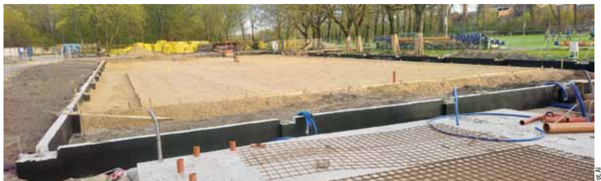
Plac budowy w kompleksie MOSiR-u przy ul. 3 Maja
