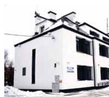
Szkoła Podstawowa w Chotumiu przeszła gruntowną modernizację
