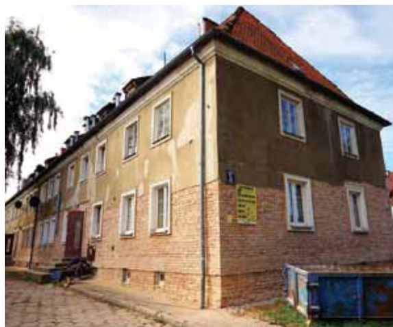
Trwa remont budynku przy ul. Okrzei 5
