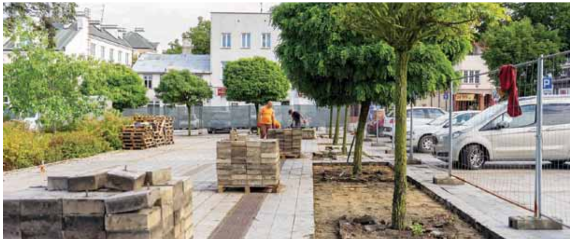
Rozpoczęły się prace na Placu Jana Pawła II
