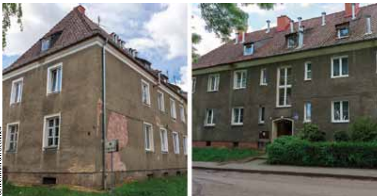
Budynki przy ul. Wyzwolenia 7 i Hallera 19 przejdą termomodernizację
