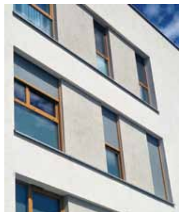
Refleksy - najbardziej dyskretna przesłona zewnętrzna, ale, jednocześnie, bardzo skuteczna w ograniczaniu nagrzewania pomieszczeń
