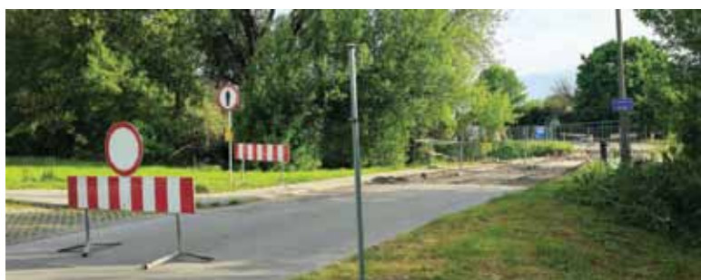
Ruszyły prace przy budowie nowego mostu w ciągu ul. Augustiańskiej
