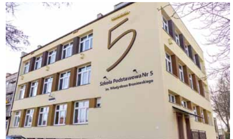
Szkoła Podstawowa nr 5 (osiedle Kargoszyn) - już zmieniona elewacja po remoncie, nowe okna
