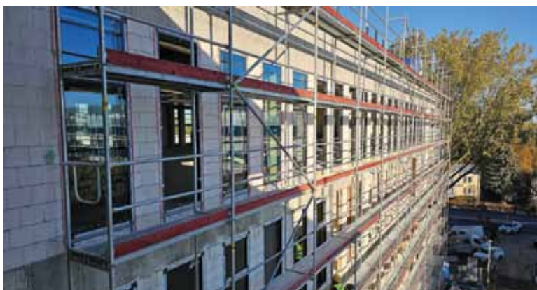
Budowa nowoczesnego Centrum Administracyjnego przechodzi w fazę wykończeniową
