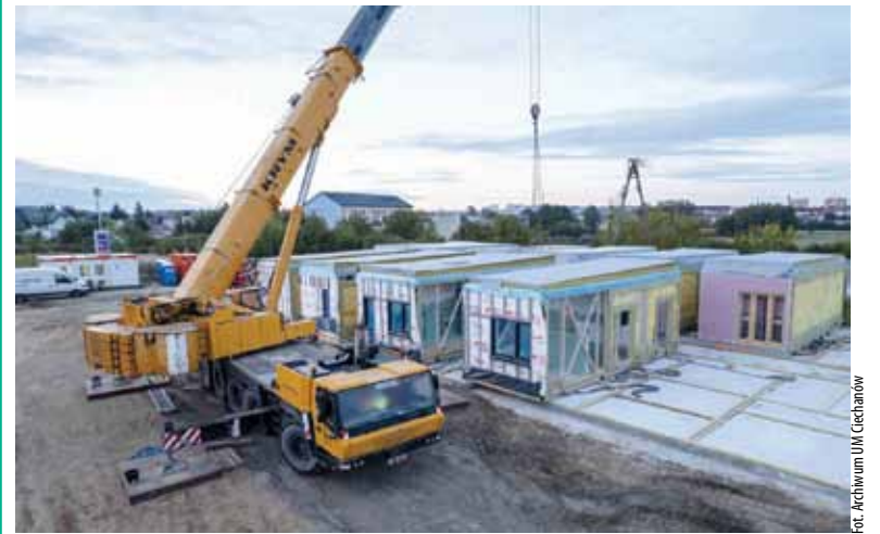
Posadowienie modułów odbywa się na wcześniej przygotowanej przez wykonawcę płycie fundamentowej
