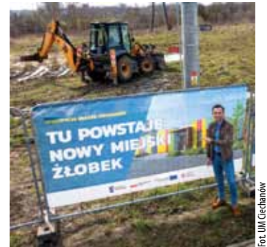
Prezydent Krzysztof Kosiński przy placu budowy nowego miejskiego żłobka
