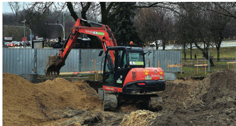
Prace przy rekonstrukcji budynku dawnej Kolei Nadwiślańskiej będą trwały około roku
