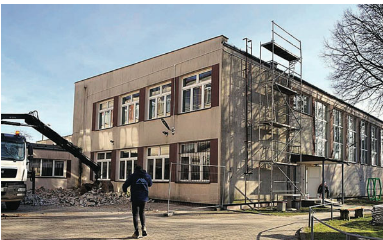
Rozpoczęła się termomodernizacja budynku Szkoły Podstawowej nr 5
