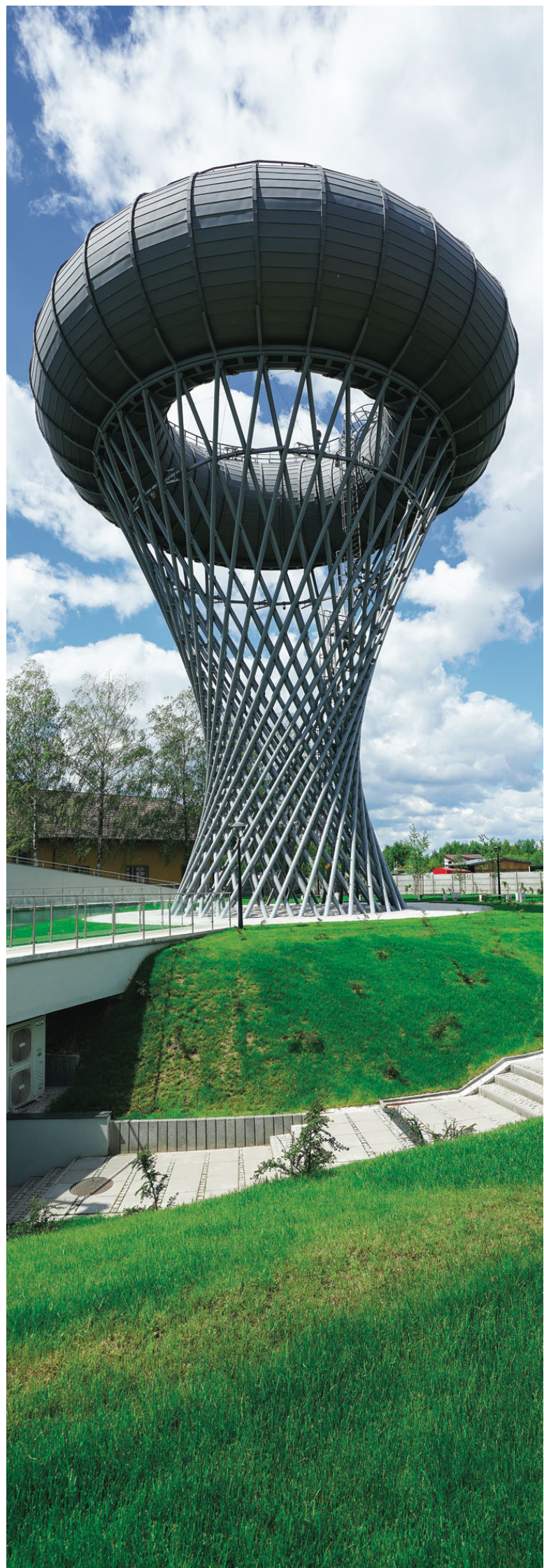
Kompleks obejmujący Wieżę Ciśnień i Park Nauki Torus jest pięknym symbolem połączenia przeszłości z przyszłością
