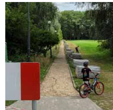
Między ul. Tatarską a kładką na Łydni powstaje nowa, dwukierunkowa ścieżka rowerowa. Remont przejdzie też istniejący tam chodnik.
