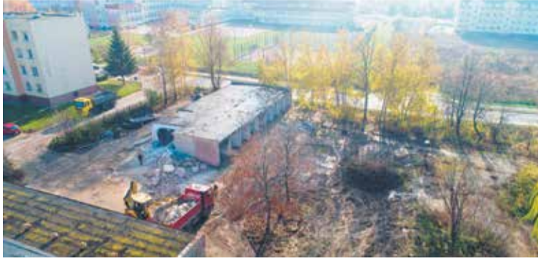
Na terenie po byłej Kolumnie Transportu Sanitarnego miasto buduje ogólnodostępny parking na 60 aut.
